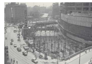
躯体工事中の北数寄屋ビル （1957/昭和 32 年）
