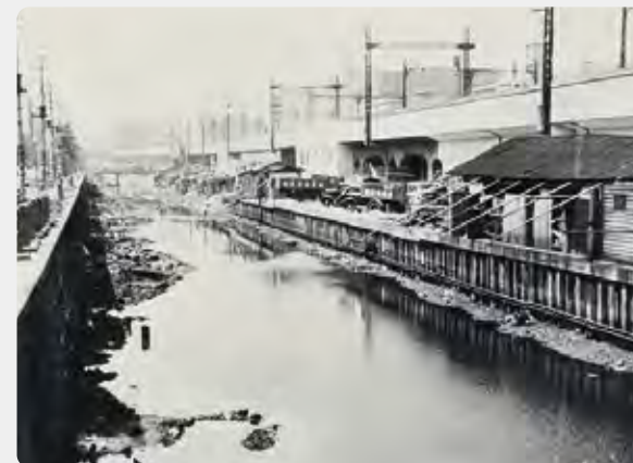
1952（昭和27）年 着工前の外堀の様子 山下ビルから新橋方面
