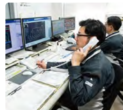
中央監視室での24時間集中管理
