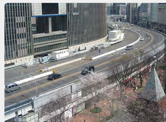
2023（令和5）年 廃止前の東京高速道路（KK線）と北数寄屋ビル
