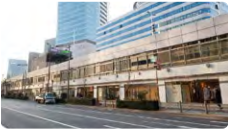
高架施設下部には14棟の賃貸スペース
